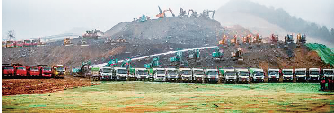
▲三一智慧钢铁城项目施工现场(资料图) 记者 易翔 摄
