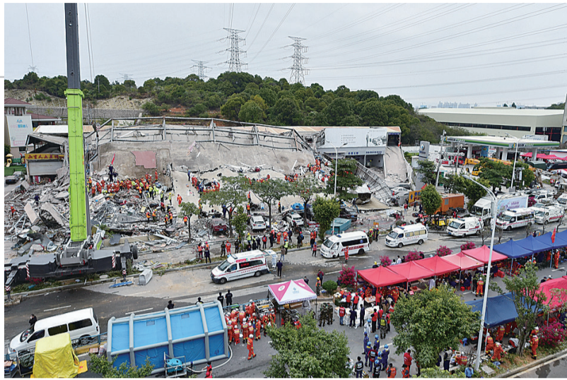
▲3月8日拍摄的福建泉州欣佳酒店坍塌事故救援现场 新华社记者 林善传 摄
