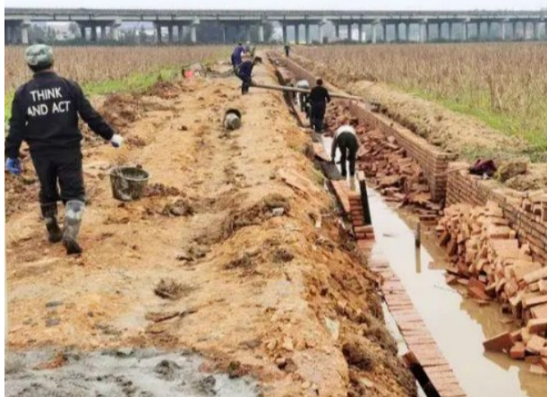
▲灌水渠和排水渠施工现场 通讯员供图
