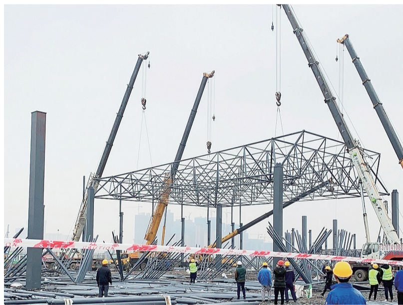
奇点汽车项目施工现场。株洲日报记者 俞强年 摄
