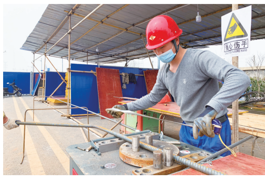
中车株机易涝点整治现场,工人正在作业。吴楚/摄
