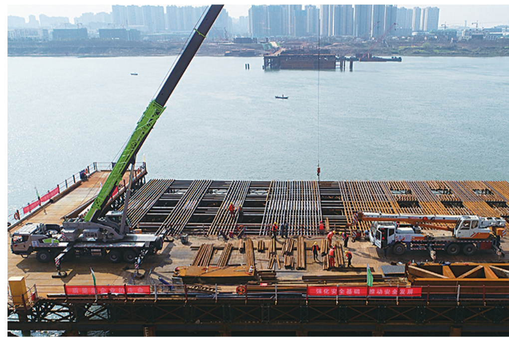
▲复工后,清水塘大桥建设稳步推进 通讯员供图
