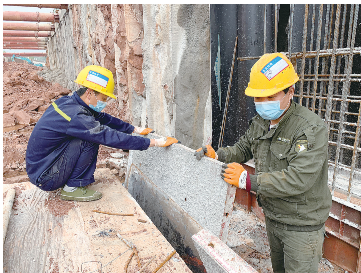
2月19日,云龙大道(洞株路株洲段)施工现场,工人们正在拆卸模板。吴楚/摄
