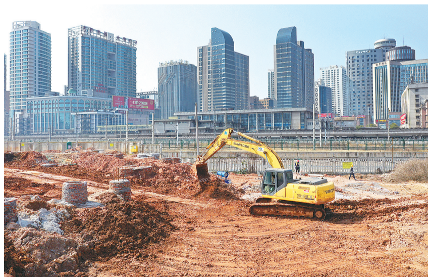
2月20日,株洲站改扩建工程现场,挖机正在作业。吴楚/摄
