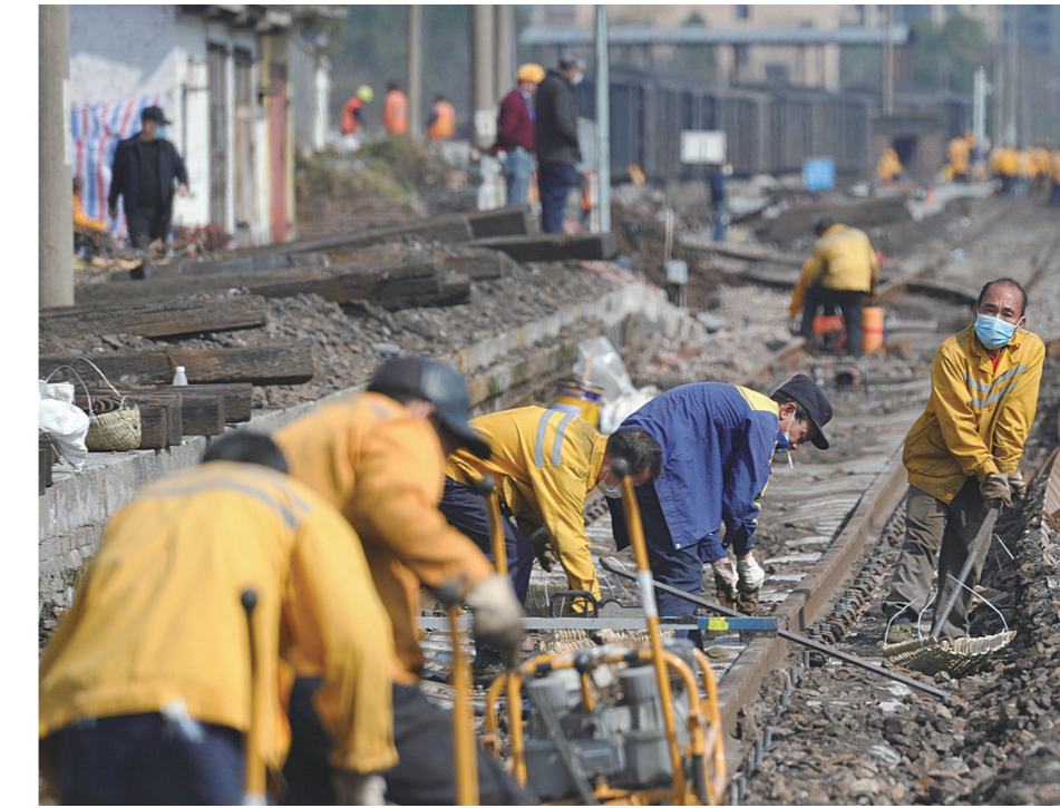
醴茶铁路施工现场。株洲日报记者 谭清云 摄
