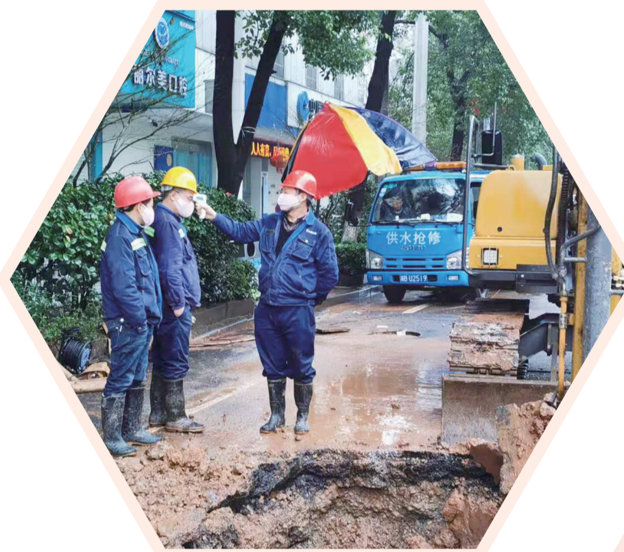
▲ 市水务集团供水抢修现场。 市水务集团供图
