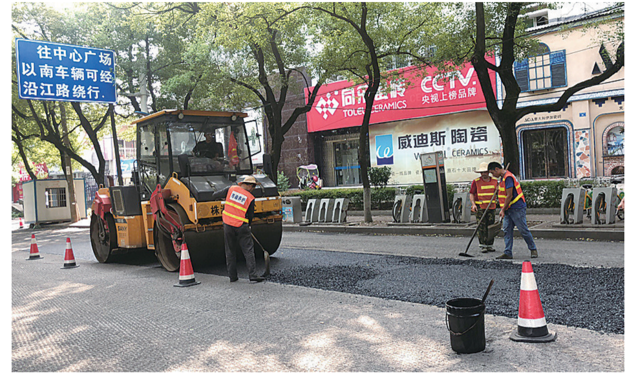
▲市政队员进行沥青摊铺修铺道路 通讯员 供图
