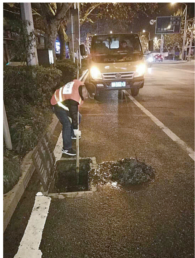
▲为了确保地下管网通畅,市政队员对管网清淤疏通 通讯员 供图
