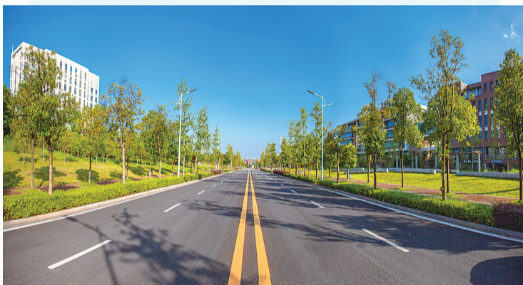
云龙示范区基础设施日益完善
