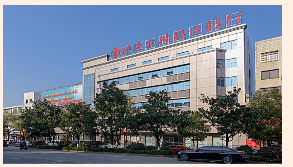
醴陵农商银行办公大楼。
