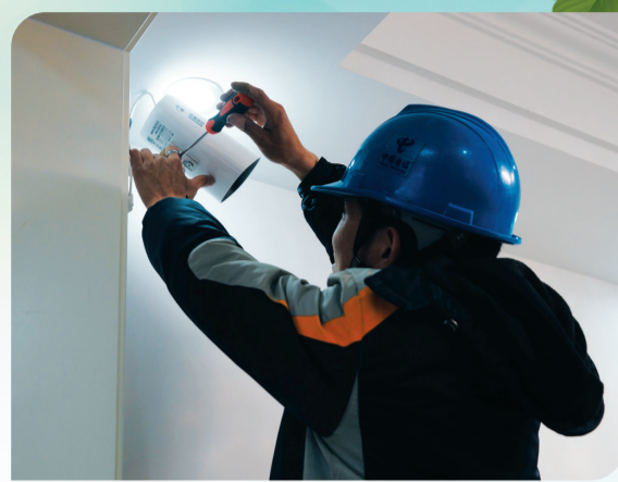
▲电信工作人员在安装监控摄像头
