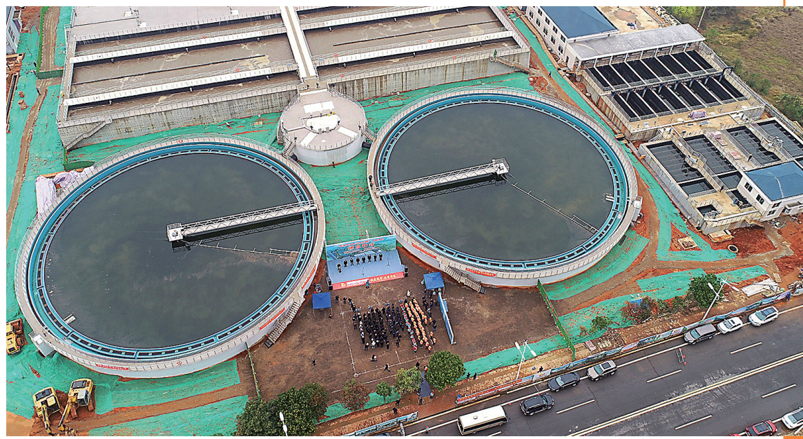
2019年年底投入试运行的河西生活污水处理厂二期。株洲日报记者 谭浩瀚 摄
