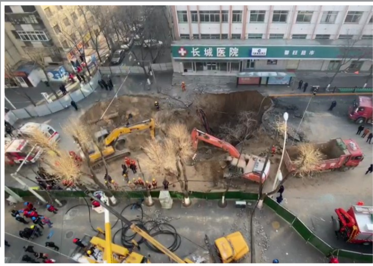
▲挖掘机正在坑洞中挖掘救援
