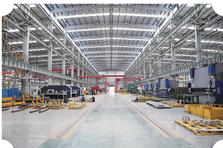
轨道交通牵引装备部件生产基地建设项目1号厂房
