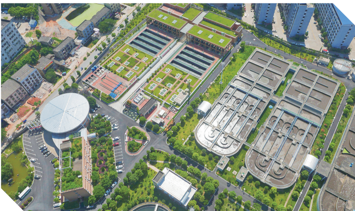
龙泉污水处理厂全景
