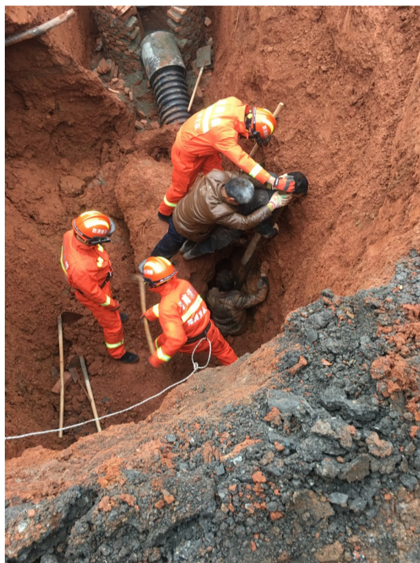
▲黄建腰部以下被泥浆埋压,消防员正在救援 消防供图
