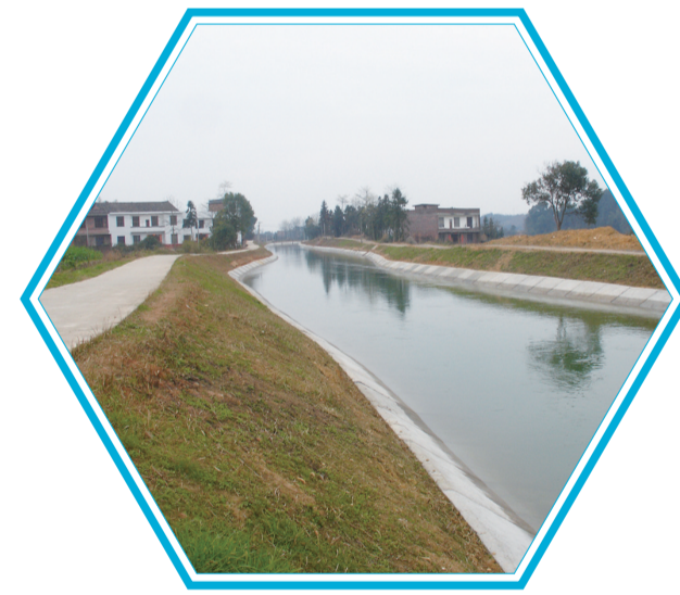
整治后的渠道水畅其流。
