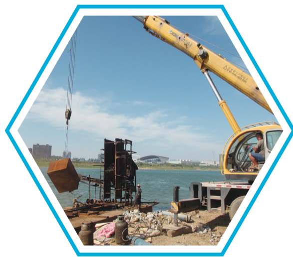
湘江株洲城区段采砂及砂场综合整治中被拆除解体的挖砂船。
