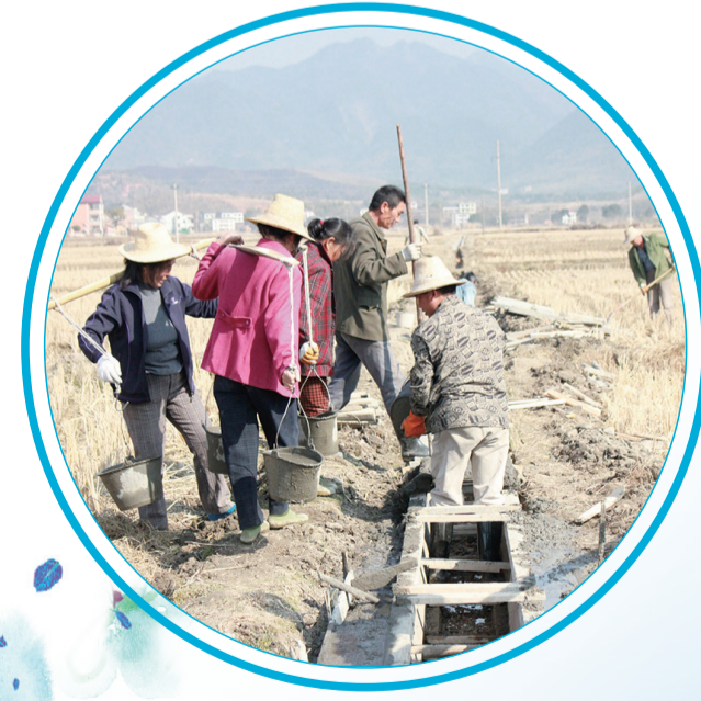
热火朝天的五小水利建设场面。
