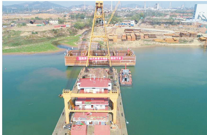
▲本月初,清水塘大桥主墩进入全面施工阶段 (资料图)
