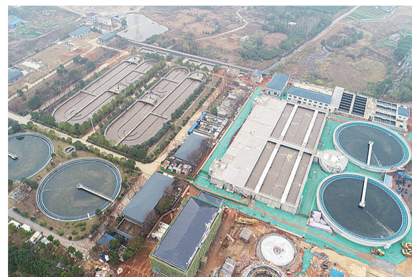
▲河西污水处理厂二期及配套管网工程PPP项目通水试运行 株洲日报记者 谭浩瀚 摄
