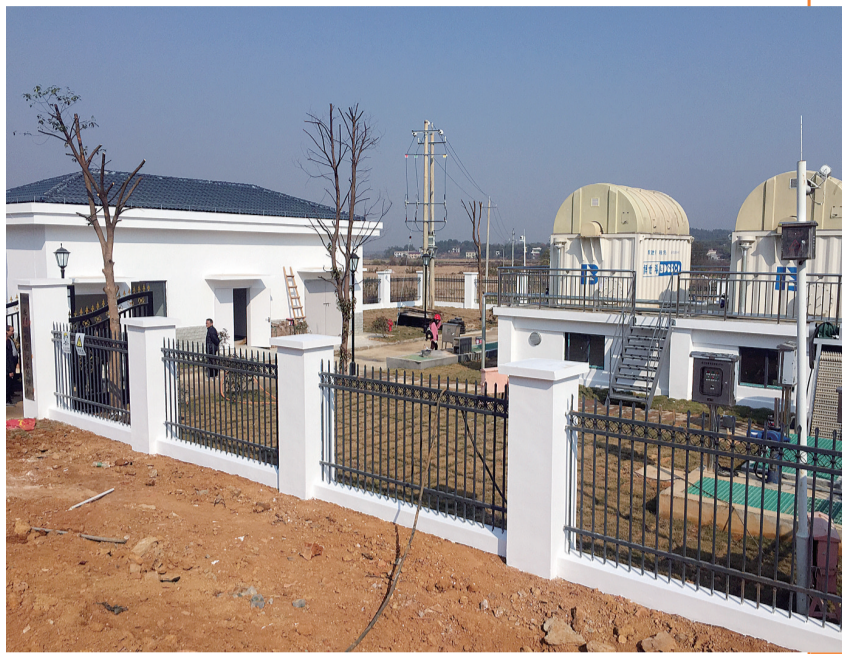
渌口区龙门镇污水处理厂白墙褐瓦,在田间分外打眼。吴楚/摄
