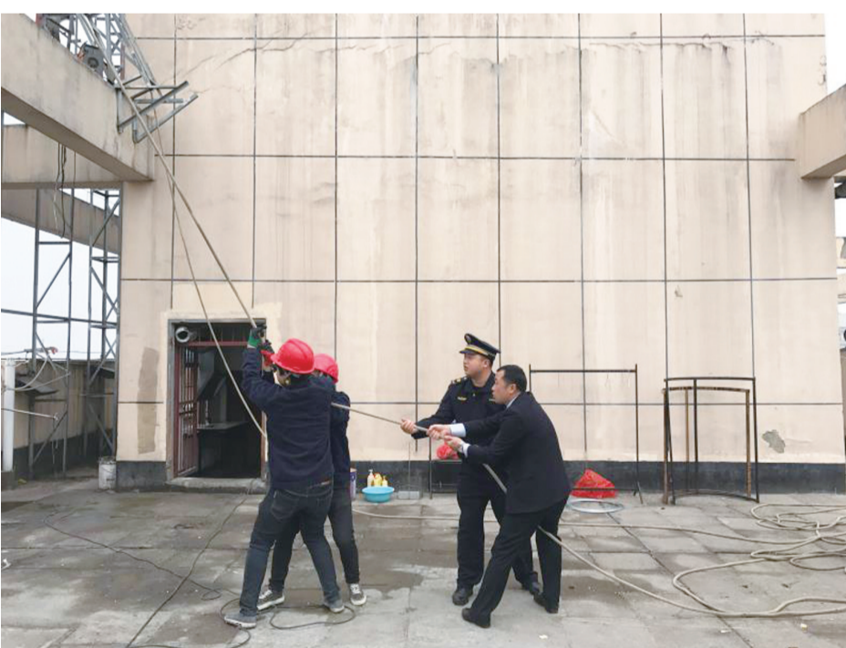
拆除美佳 yang 范广告招牌。
