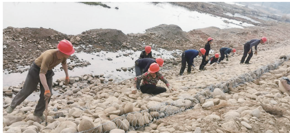
湖口镇浣溪村,洙水东岸加固施工现场。黄琳 供图
