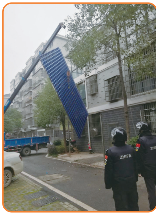
吊车将小区违法搭建雨棚吊起拆除。
