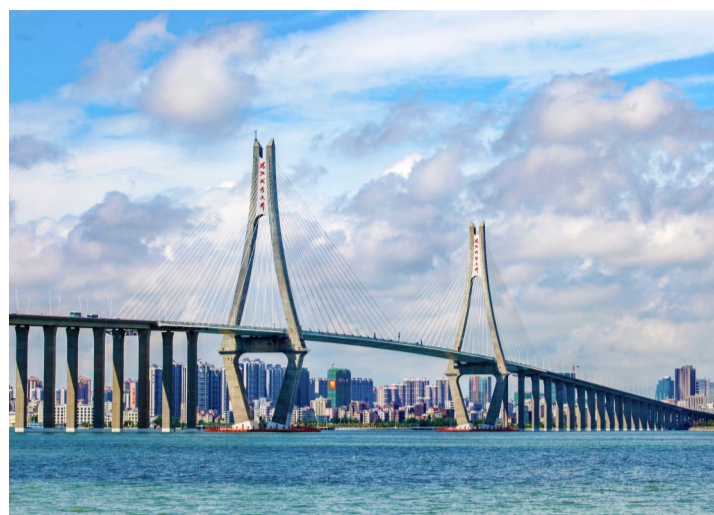
▲湛江海湾大桥
