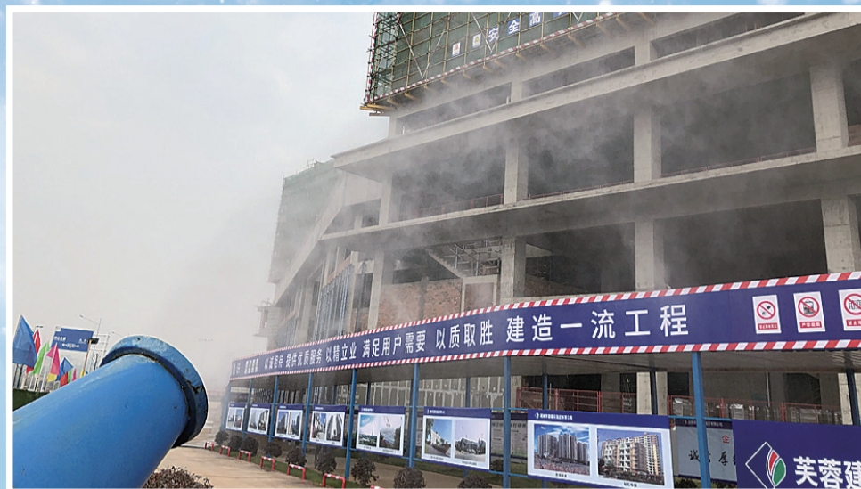
▲项目现场的喷淋设备,有效抑制了扬尘 记者 周蒿 摄
