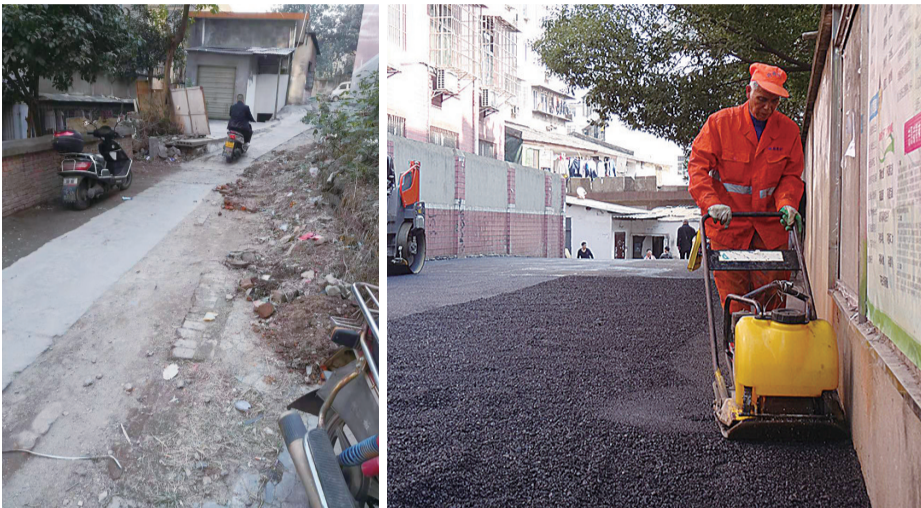
▲市五中旁边有一条100多米长的路,左图为年久失修、受损严重的路,右图为道路正在施工 通讯员供图
