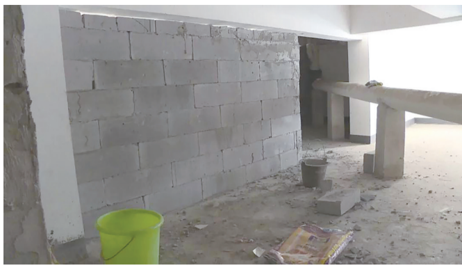
5栋转换层被圈占,里面情况不明。株洲日报记者 沈全华 摄
