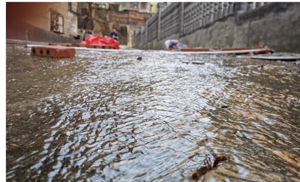
▲庆云山三村水泵房漏出的水 记者 姚时美 摄
