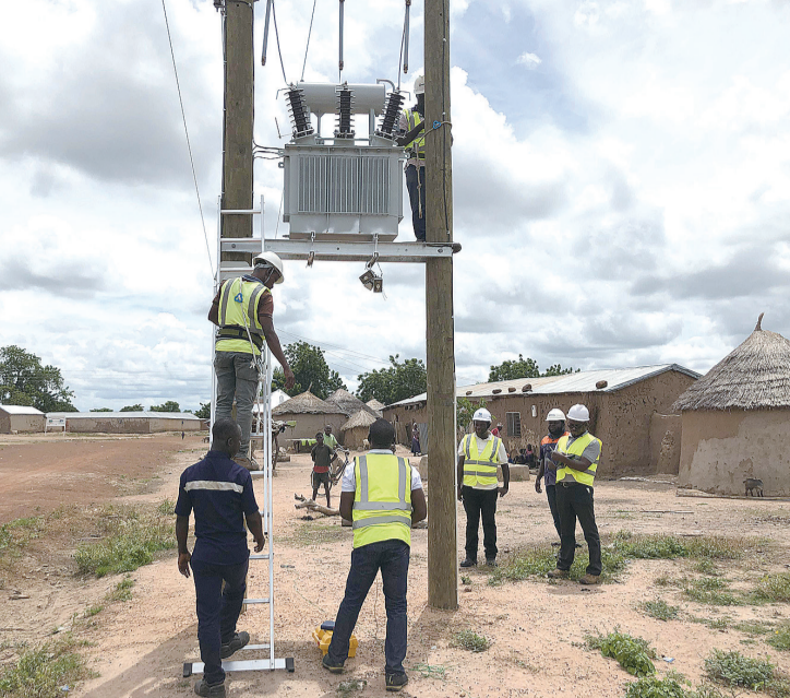
图为工作人员在对电力设施进行预验收。
