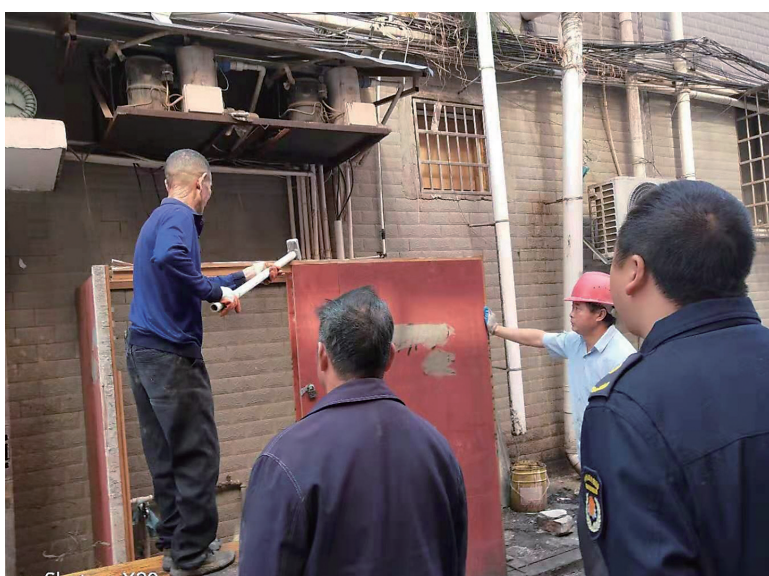
严塘镇集中拆除路边违章搭建。杨谭光 供图
