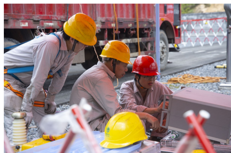
现场对供电部件进行会诊调试。
