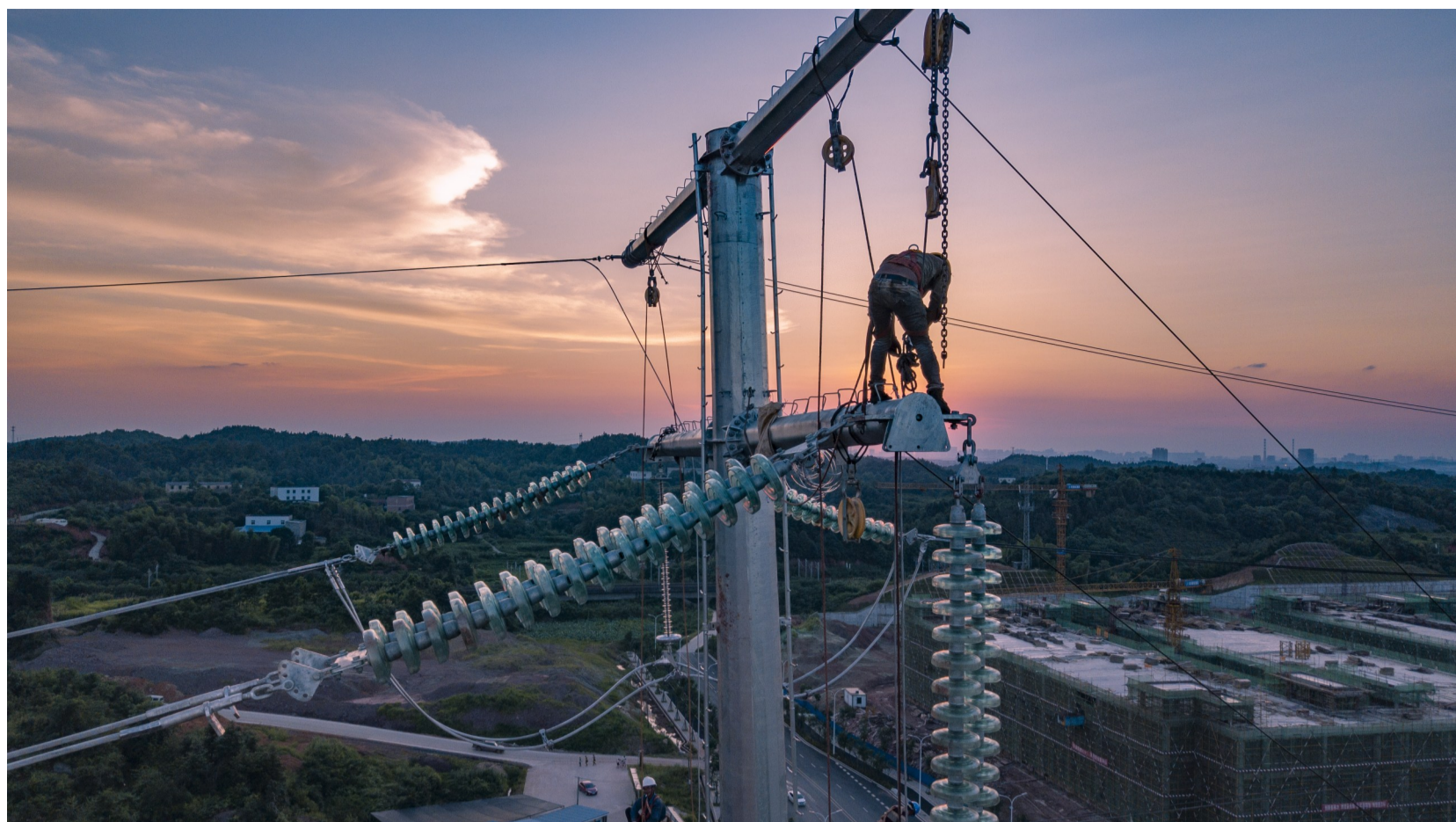
在天元区高科园,伴随着晚霞,杆线迁移施工即将结束。
