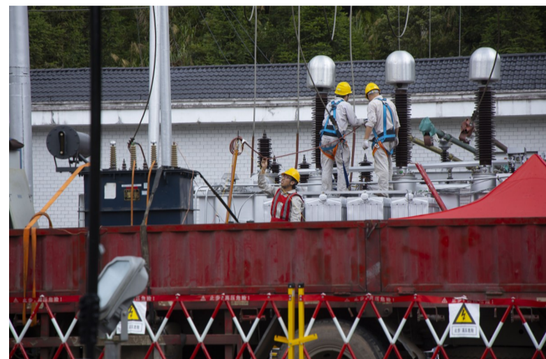
炎陵县110千伏中村变电站,集中停电检修。
