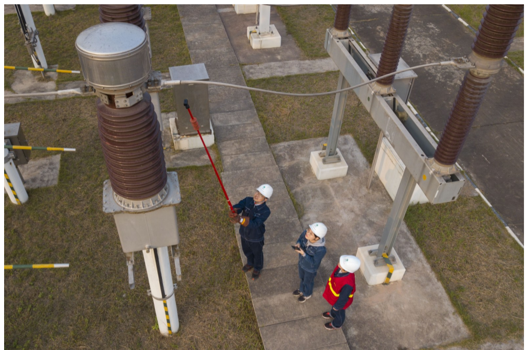
使用全方位观察记录仪,在安全距离下观察、记录设备运行状况。
