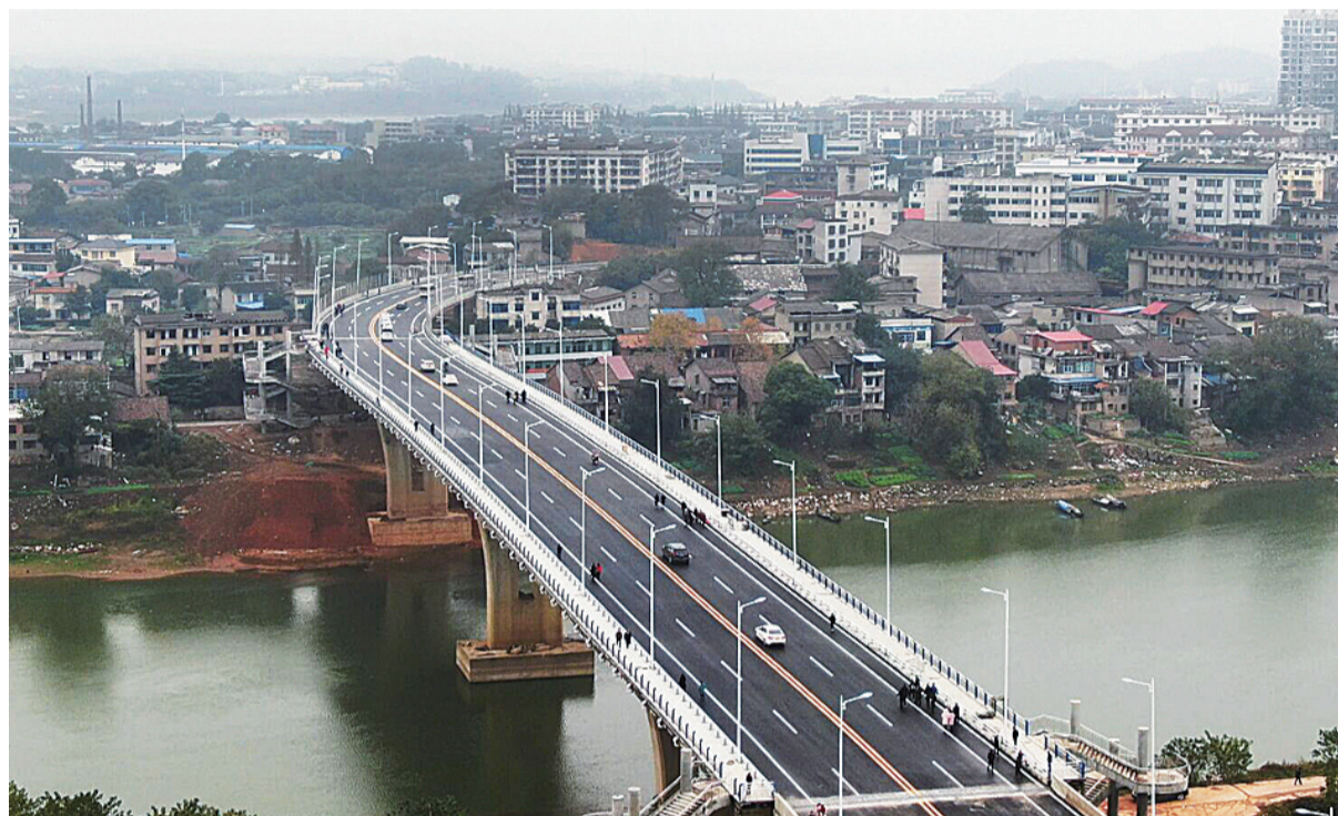
▲渌水二桥全长884米,主桥宽26米,双向4车道 通讯员 何涛 供图
