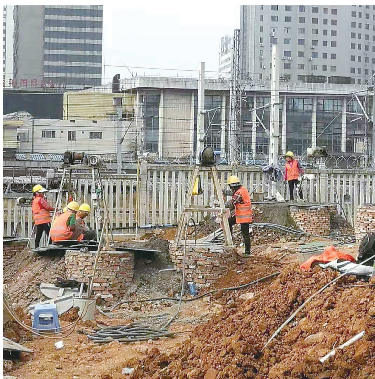
火车站改扩建工程现场,工人们正在进行桩基基础作业。吴楚摄
