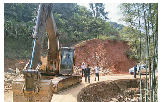
▲太长线施工现场 记者 李卉 摄
