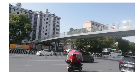
▲荷塘区陡岭坡已经架起了人行天桥 记者 李卉 摄
