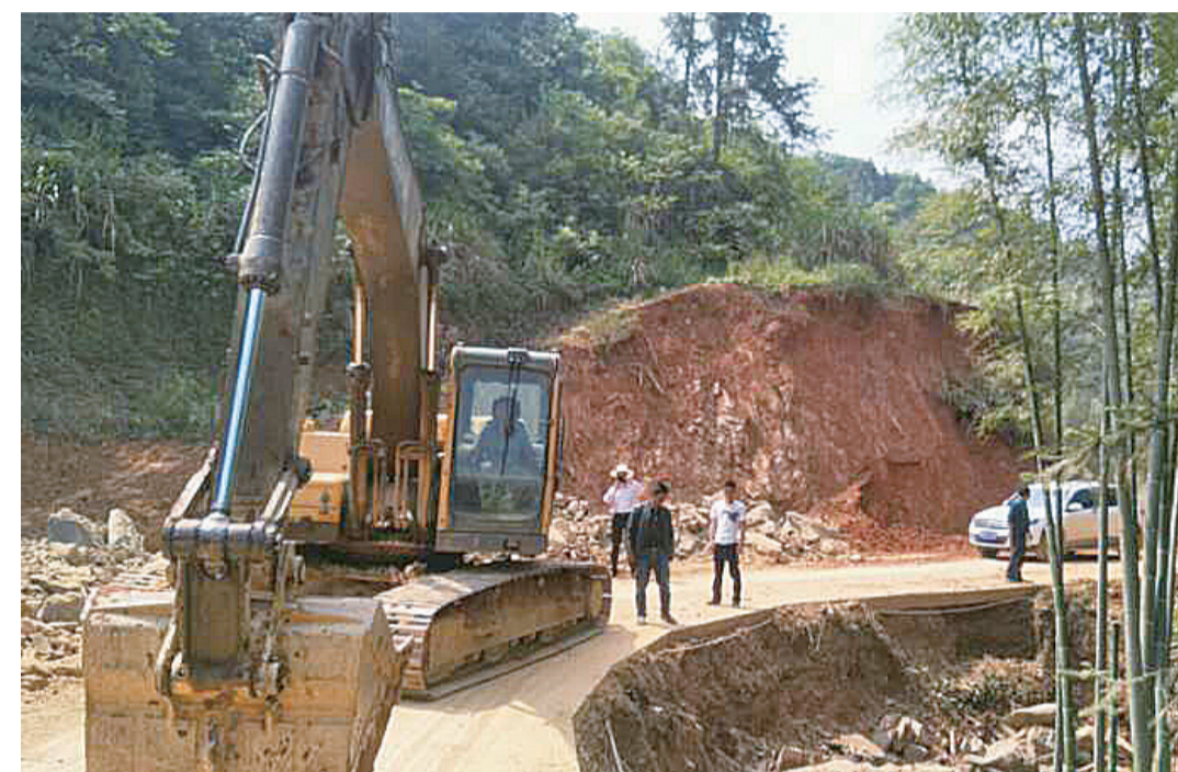
▲太长线施工现场 记者 李卉 摄
