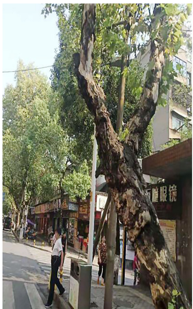
▲人民路沿线,法国梧桐树出现腐朽、空心等情况 通讯员供图
