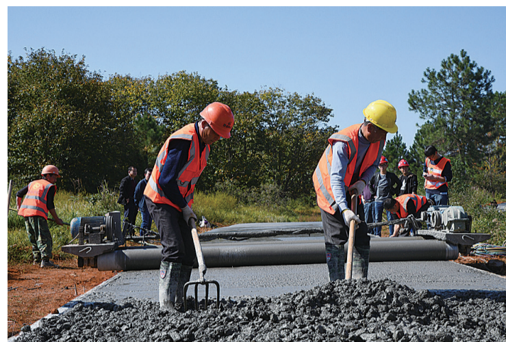
▲工人正在加紧修建农村公路 通讯员供图
