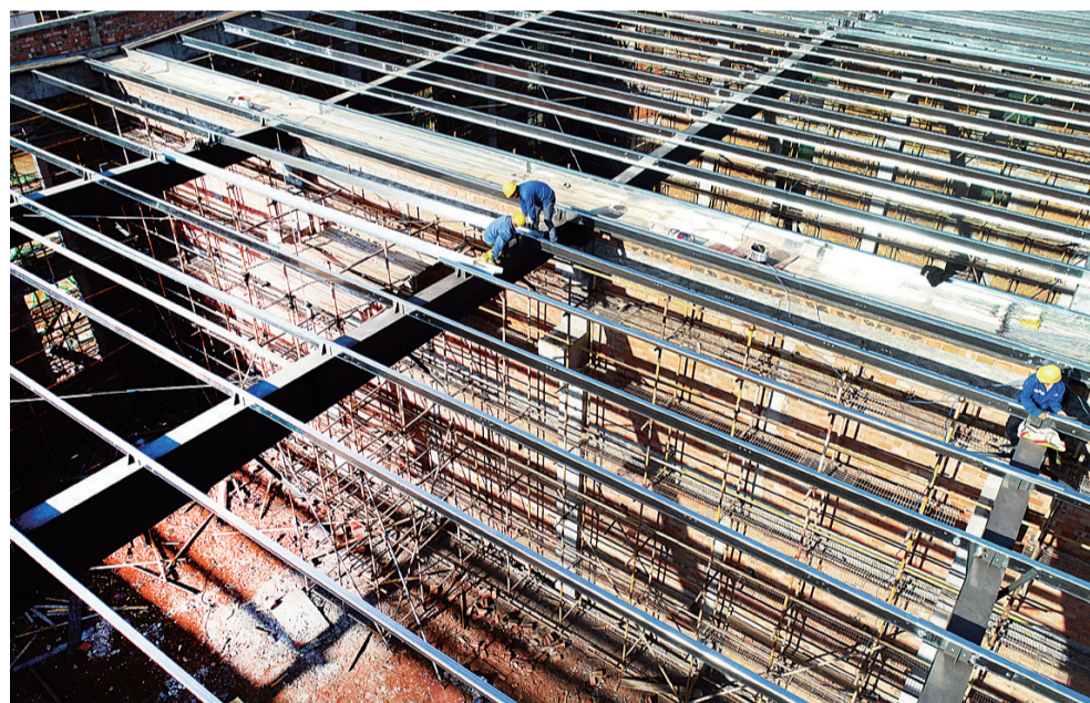
嘉德工业园二期标准厂房施工现场。株洲日报记者 谭浩瀚 摄
