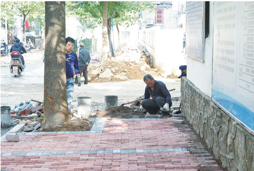
老旧小区改造现场。通讯员供图
