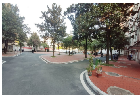
▲改造完毕的轴承厂小区 记者 周蒿 摄
