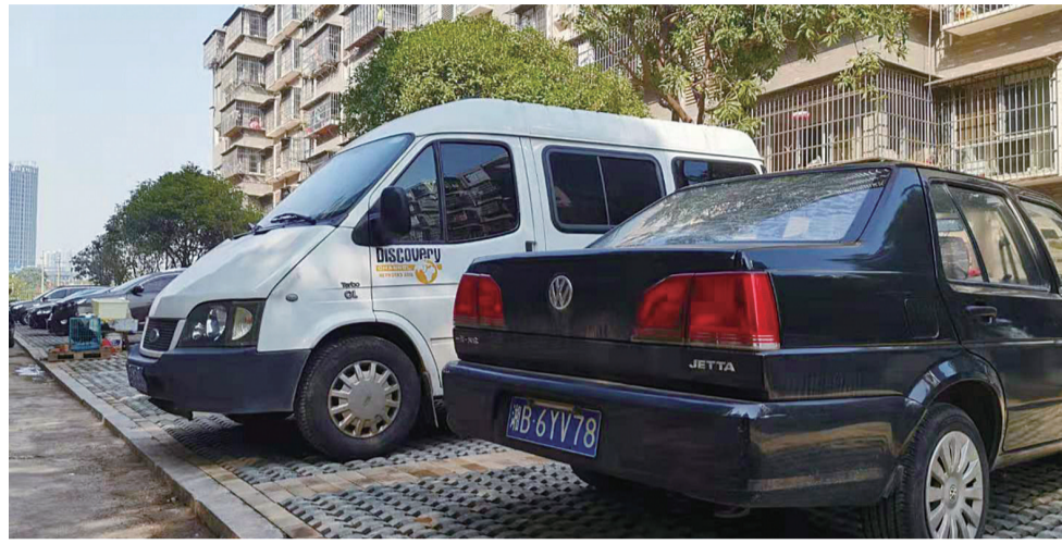
东湖小区在建的生态停车位。沈全华 摄
