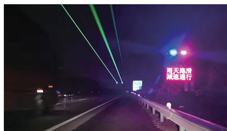
▲激光束可以消除司机疲劳感,还能提高恶劣天气条件下的路面能见度 通讯员供图
