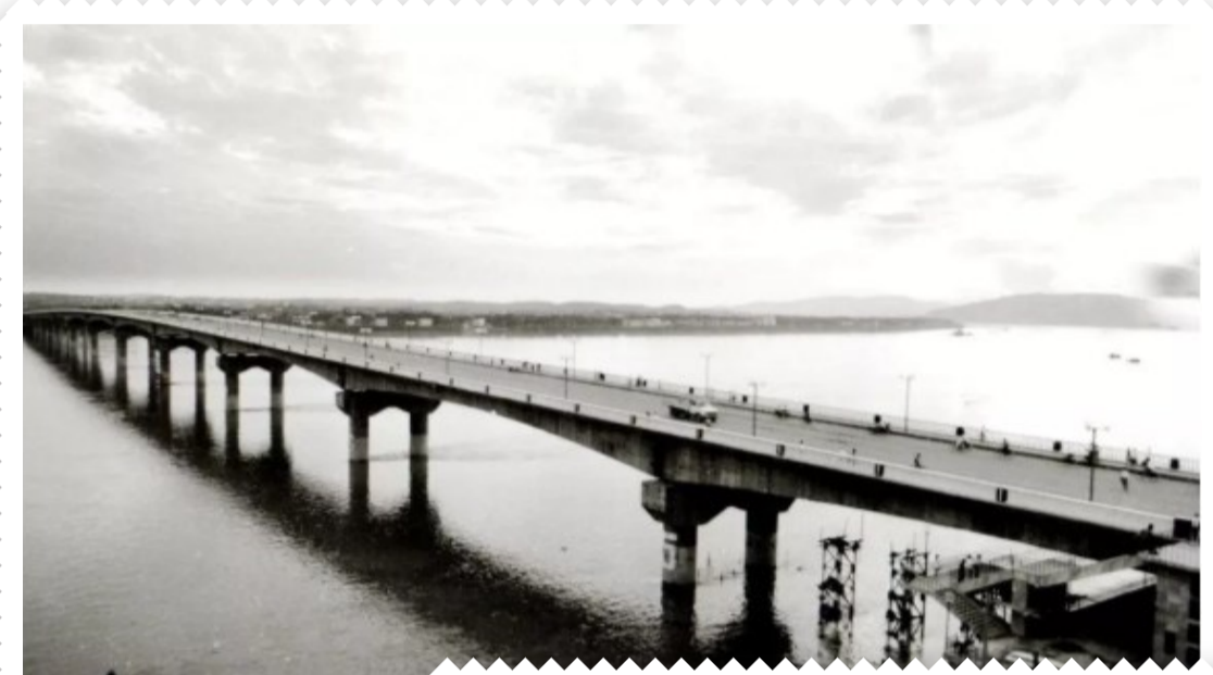
◀株洲大桥桥东旧貌
