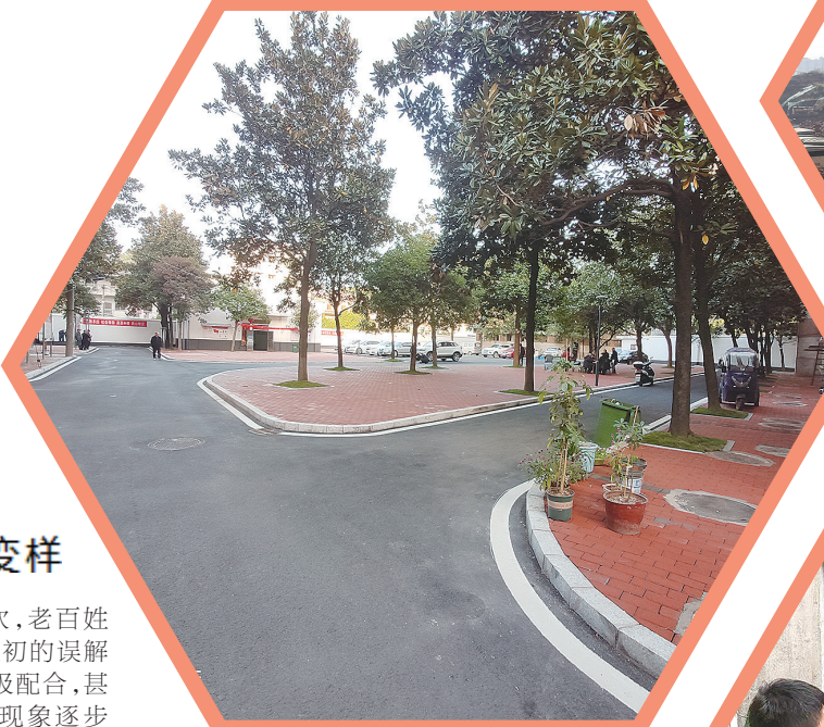
轴承厂小区提质改造后，环境大为改善
