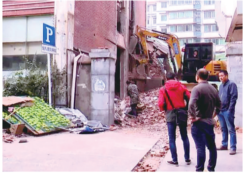
装修施工工地扰民被投诉。沈全华 摄
