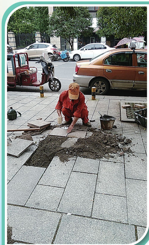
▲荷塘城管市政部门修缮辖区行道 通讯员供图
