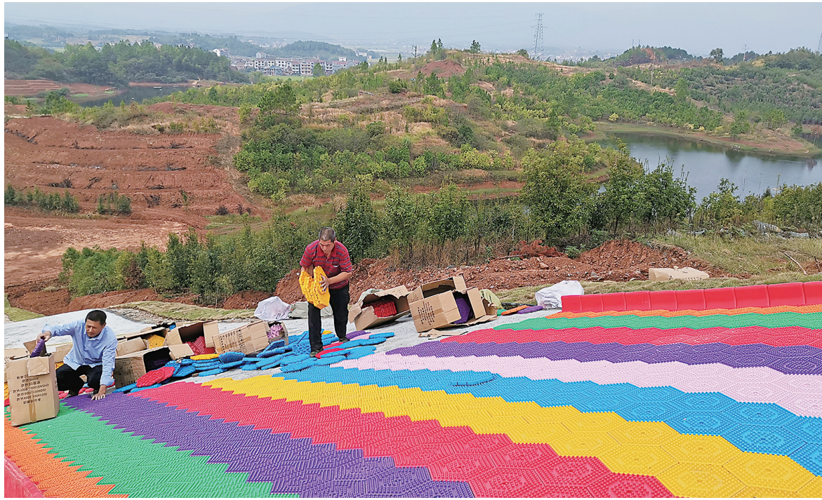
10月16日,在位于茶陵县马江镇的湖南慧科生态教育研学旅行基地内,工人们正在对基地内的七彩旱地滑草项目进行安装施工。据了解,该项目落差70米,长170米,是省内滑道较长的旱地滑草项目之一。湖南慧科生态教育研学旅行基地是茶陵县重点招商项目,总面积4000余亩,其中水面湿地500余亩。项目建成后,每日可接待上千人研学。 株洲日报记者 谭浩瀚 摄
